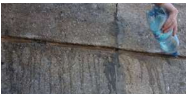
Рисунок 7 – увлажнение штраб и отверстий водой.
