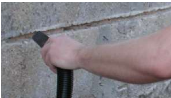
Рисунок 4 – очистка штраб и отверстий.
