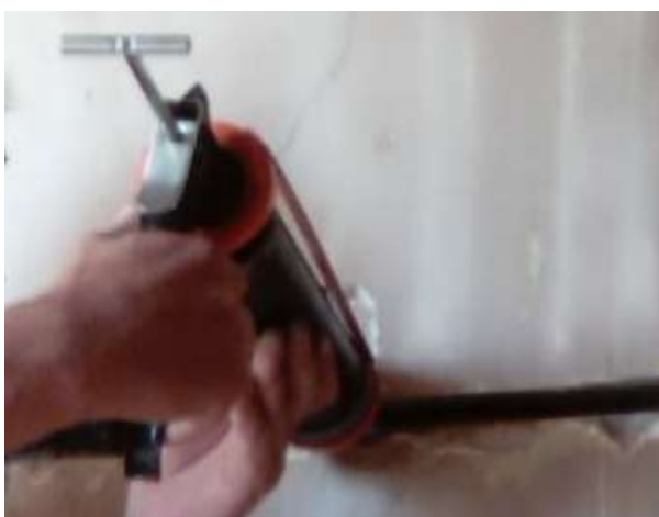
Рисунок 8 – укладка первого слоя раствора Sure Grout.
