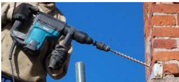
Рисунок 3 – выполнение отверстий.
