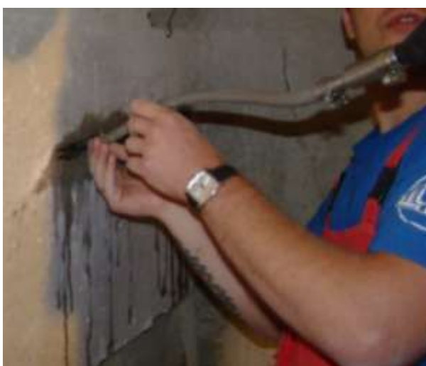
Рисунок 9 – заполнение отверстий раствором Sure Grout.
