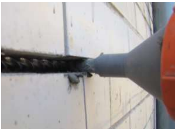
Рисунок 11 – укладка второго слоя раствора.
