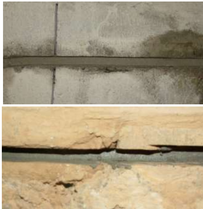
Рисунок 13 – общий вид штрабы после выполнения работ.
