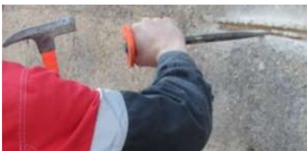
Рисунок 2 – выполнение (очистка) штраб.
