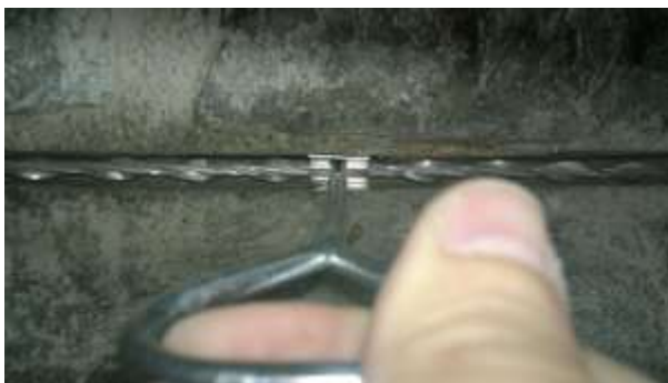
Рисунок 10 – фиксация стержней в штрабе стальными пластинками Sure Clip
